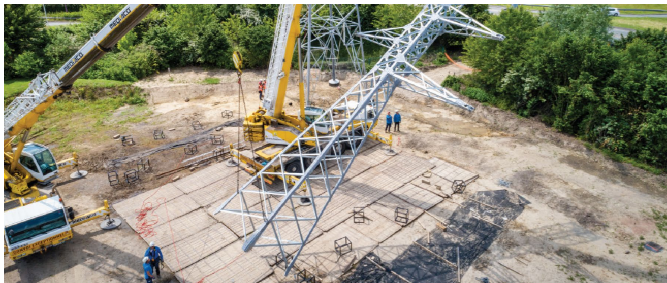
Figure 39 - Photo d'une plateforme de levage de pylône
