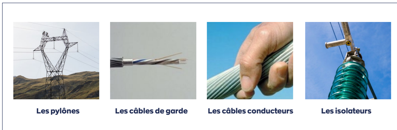
Figure 37 - Photos des composants d'une ligne aérienne
